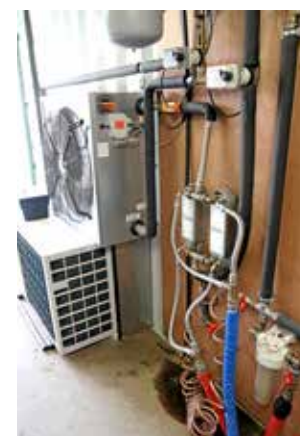
Värmen från motorerna värmer röt-kammaren.
