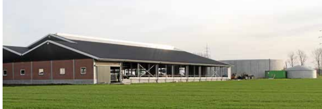
En några månader gammal 22 kilowattsanläggning intill ett nybyggt nötstall med skraputgödsling i stället för helpsaltsgolv.
