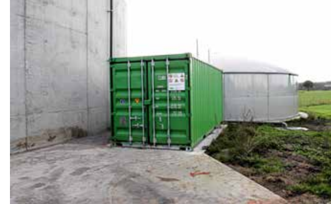
Biogasanläggningen med tekniken i containern och röt-kammaren i bakgrunden, placerad intill en rötrest/gödselbrunn att växa med. Det duger bra med en plan, hårdgjord yta, men här föredrog lantbrukaren att gjuta en platta till anläggningen.
